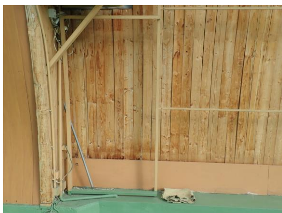
Obr. 8 Středová mezera mezi posuvnými prvky, mechanika posuvu sekcí
