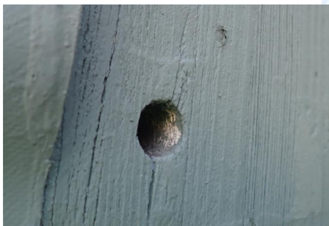
Obr. 9 Sonda do dřevěného vazníku s detailem
