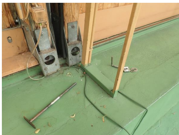
Obr. 8 Středová mezera mezi posuvnými prvky, mechanika posuvu sekcí
