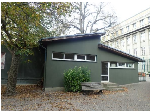
Obr. 14 Úpravy vnějšího povrchu přístavby
