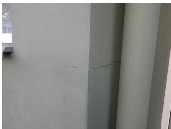
Obr. 5 Stav stěn přístavby – vodorovné trhliny
