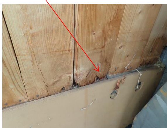
Obr. 8 Středová mezera mezi posuvnými prvky, mechanika posuvu sekcí
