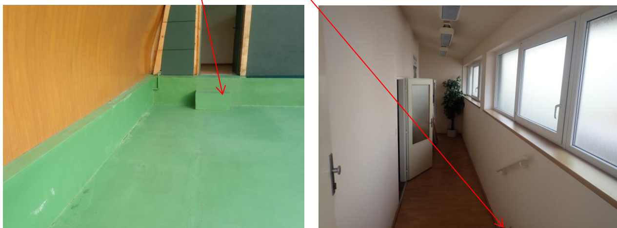
Obr. 16 Schodišťové stupně v hale a v místnosti 1.02
