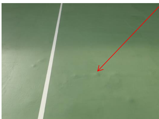
Obr. 19 Lokální nerovnosti hrací plochy – výstupky
