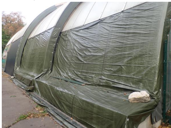
Obr. 6 Výplně sekcí stěn – pohled z venkovní strany
