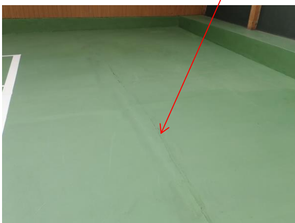
Obr. 19 Lokální nerovnosti hrací plochy – výstupky
