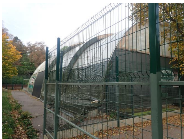
Obr. 3 Štítová stěna haly
