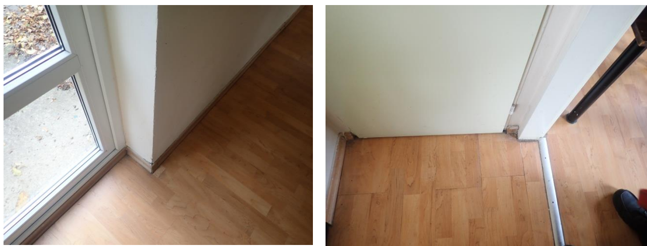
Obr. 17 Vnější a vnitřní dveře s osazenou přechodovou lištou
