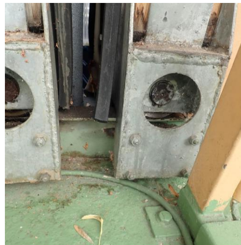
Obr. 8 Středová mezera mezi posuvnými prvky, mechanika posuvu sekcí
