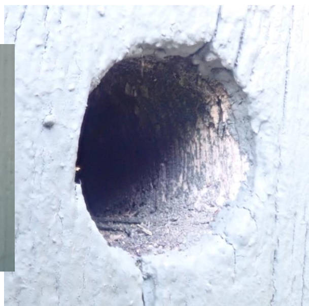
Obr. 9 Sonda do dřevěného vazníku s detailem
