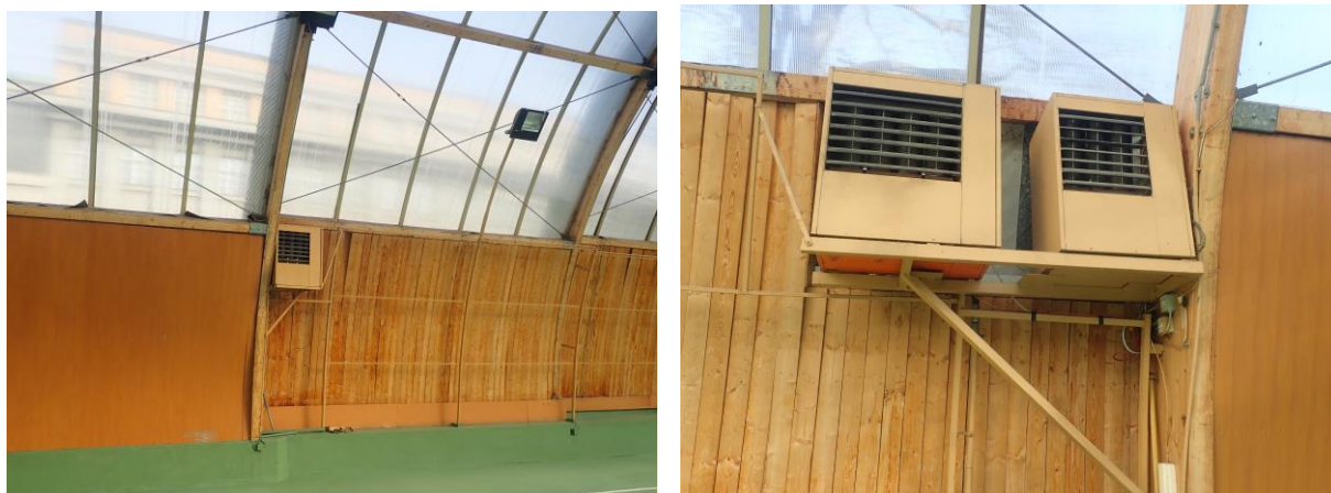
Obr. 22 Vytápění haly – plynové přímotopy tzv. Robury
